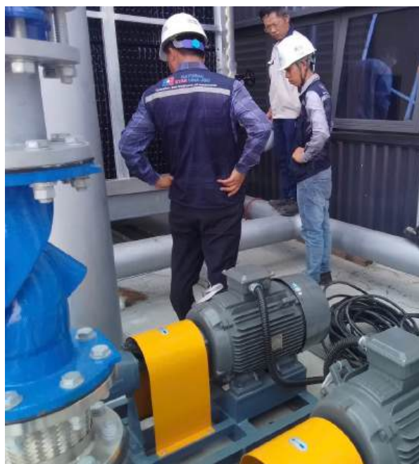
KHẢO SÁT, TƯ VẤN LẮP ĐẶT SURVEY, INSTALLATION CONSULTATION
