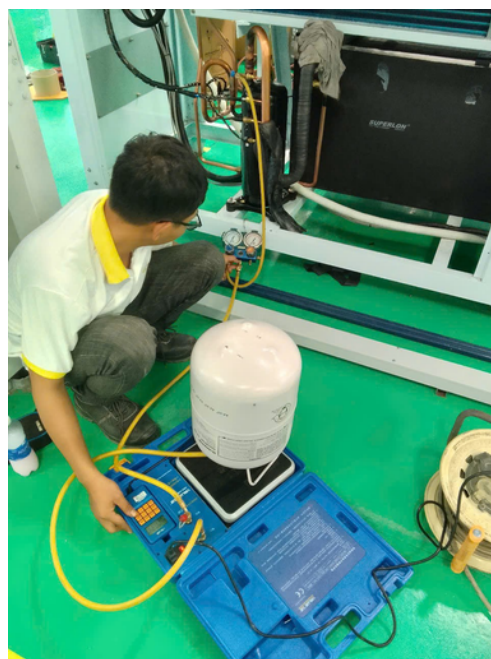
BẢO TRÌ BẢO DƯỠNG CHILLER CHILLER MAINTENANCE
